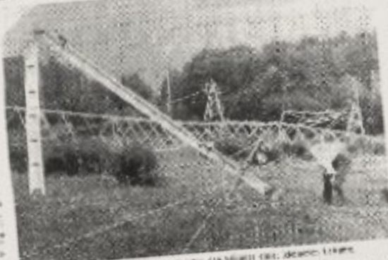
Die Hochspannungsleitung wurde durch die Bomben stark beschädigt.
