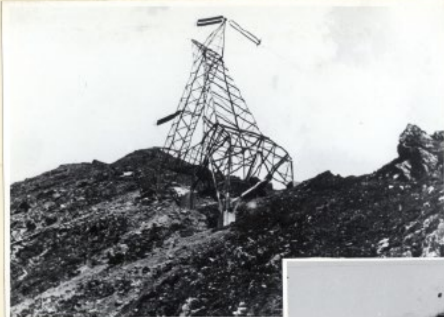
Der gesprengte Hochspannungsmast
